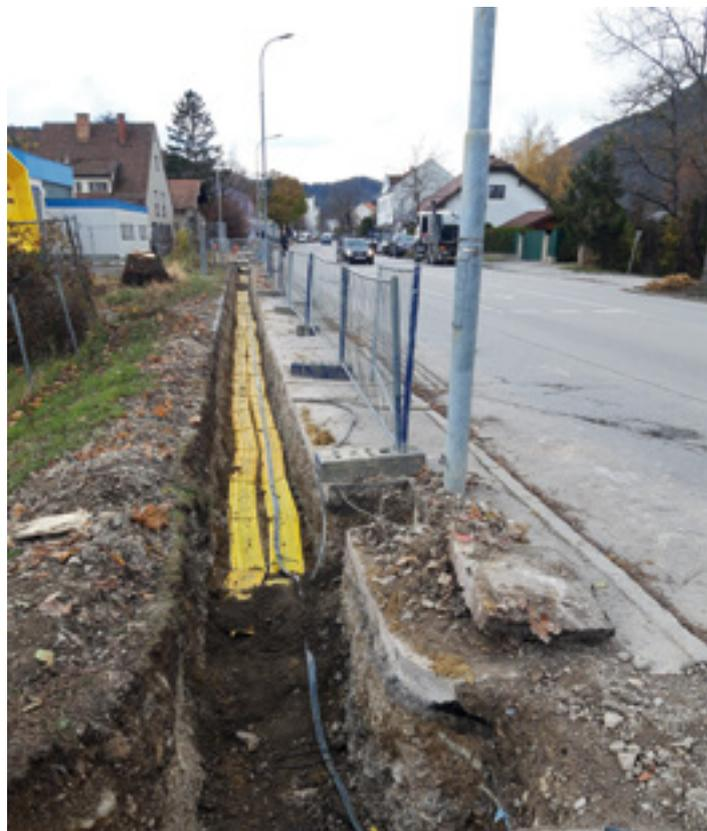
Im Zuge der Erneuerung der Stromleitungen durch die Netz NÖ in der Wiener Straße vom Landespensionistenheim bis Lidl, wurde die Verkabelung der Straßenbeleuchtung ebenfalls erneuert. Die Leitungen waren aufgrund des Alters und der geringen Einbautiefe zu erneuern.
