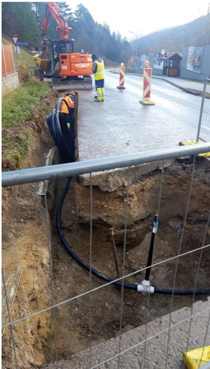
Anfang Dezember 2021 wurden die Objekte am Klammerweg mit einer neuen Verbindungsleitung an das Trinkwassernetz der Stadtgemeinde angeschlossen. Vorher erfolgte die Versorgung über die Marktgemeinde Schottwien. Die Arbeiten wurden von der Firma Porr, in Zusammenarbeit mit dem Wasserwerk ausgeführt. Die Kosten betragen netto € 19.000,-.
